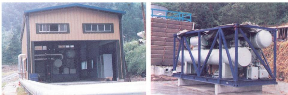
圖三 昔日宜蘭土場地熱電廠（260kW 雙循環發電機）
