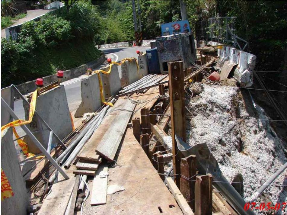
圖 7 台 7 省道道路邊坡因豪雨崩塌滑動情形
