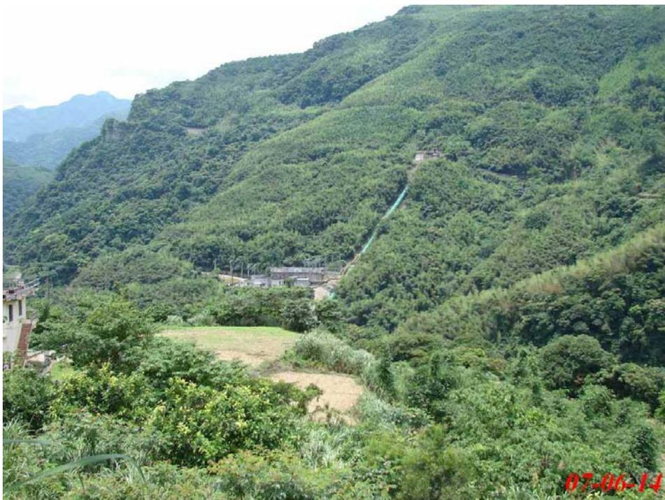
圖 8 義興地區與義興電廠因地層破碎邊坡仍持續變形
