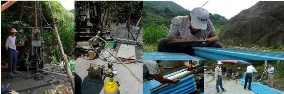
圖四、水文地質鑽探現地施作情形
