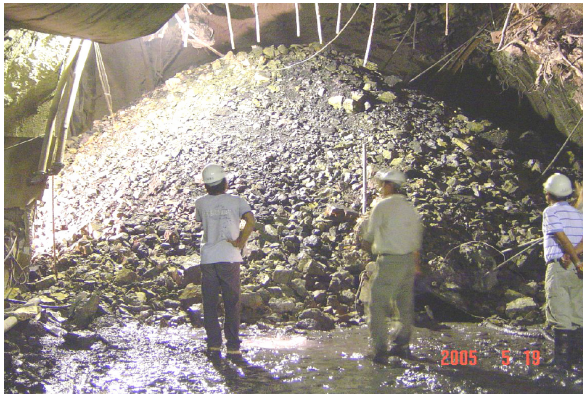
圖 9 案例隧道東行線交叉段頂拱抽坍情形
