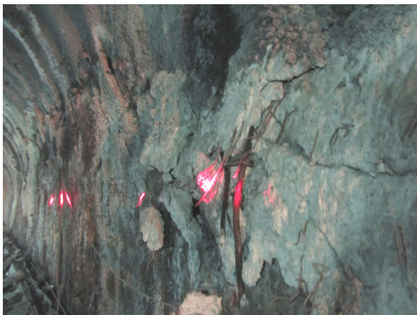
圖 7 案例西引水隧道斷層帶鋼支保挫屈破壞情形
