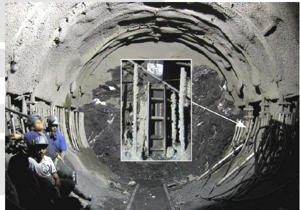
圖 10 高岩覆隧道採用被動式支撐工情形
