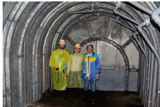
圖 6 梨山排水廊道及廊道內橫向集水設備
