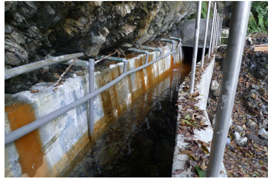
圖 5 西寶國小附近橫向集水設施
