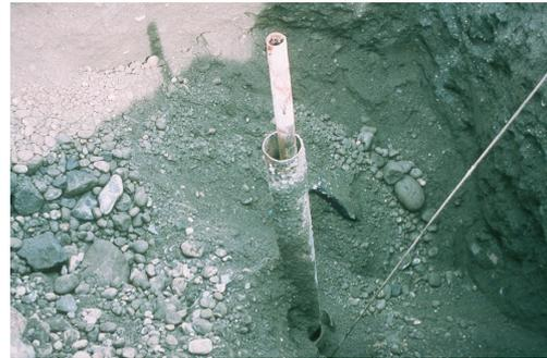
圖 3 W.A.C. Bennett 陷孔處下方垂直立管
