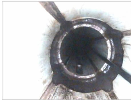
圖 14 抽水測試時 K1 管節接頭出水情形
