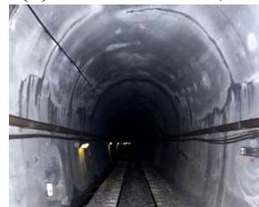
(c)隧道左右側壁金屬材質保護管道
