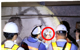
(b) 現場檢核之裂縫照片
