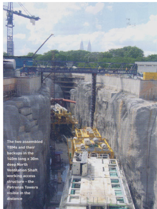
照片 2 尺寸為 140 m 長、30 m 寬的北端通風豎井內，已安裝完成的兩部 TBM 與其後援系統。 (資料來源：參考文獻 2.)
