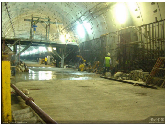
◀ 照片 4 雙層道路底板施工現場 (資料來源：參考文獻 4.)
