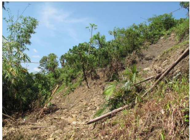
圖 21 莫拉克颱風後寶隆場址坡趾處局部崩滑
