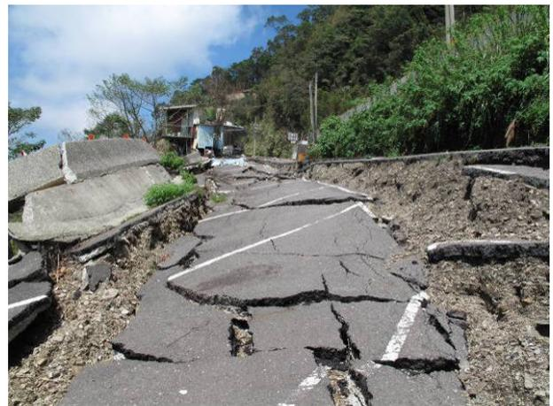
圖 9 莫拉克颱風藤枝地區崩滑破壞情形
