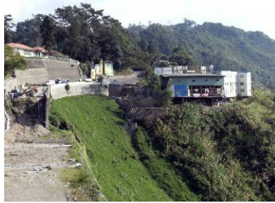
(d) 坡頂整治狀況(2008)
