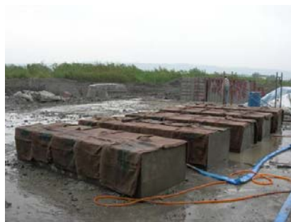
(h) 方形混凝土塊拆模及養護
