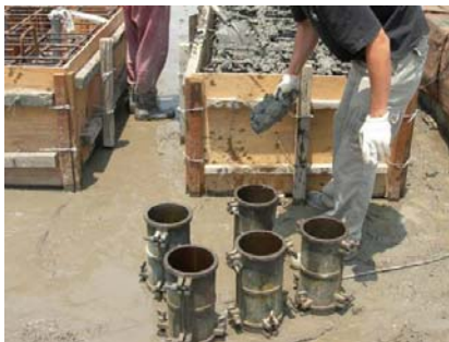
(g) 混凝土圓柱試體隨機取樣
