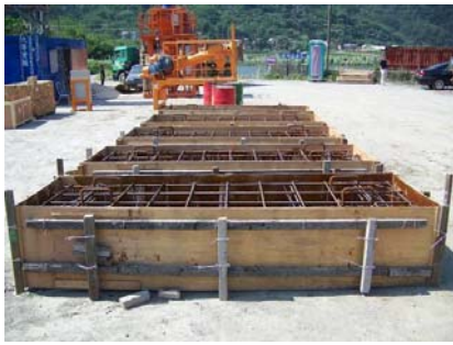
(a) 方形混凝土塊模版組立及鋼筋綁紮
