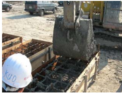
(e) 方形混凝土塊澆置
