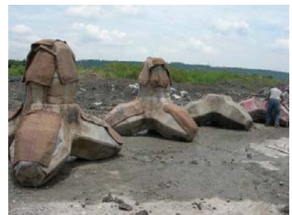
(i) 消波塊拆模及養護
