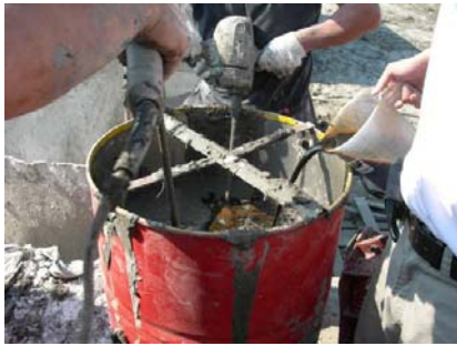
(d) 淤泥添加固化劑及附加劑均勻攪拌
