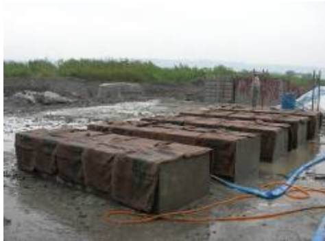
(c) 混凝土塊養護
