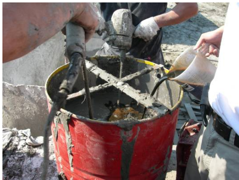
(a) 淤泥添加固化劑及附加劑均勻攪拌
