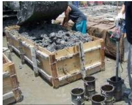
(b) 混凝土澆置及圓柱試體取樣
