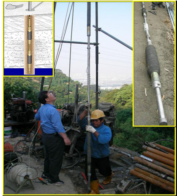
圖七 現地雙栓塞透水試驗
