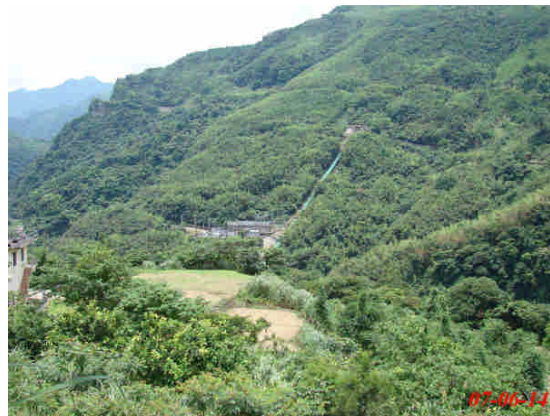
圖2 義興崩塌地遠景全貌
