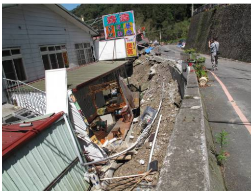
(a)西側房屋傾倒狀況，塌陷約一層樓高 (224918, 2551739)
