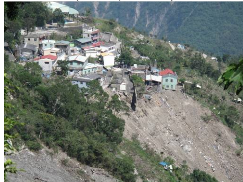
(f)下邊坡崩滑已危及村民住宅及道路 (224263, 2515676)
