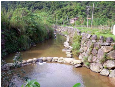
(a) 砌石固床工(台北市內溝溪上游)
