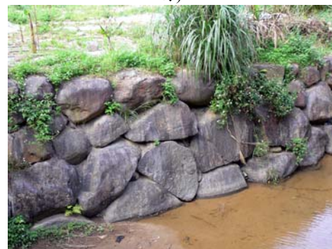
(d) 混凝土基礎單階砌石護岸(台北市內溝溪上游)
