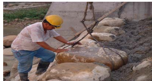
圖三 漿砌石施工現場作業照片
