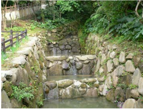
(e) 跌水式混凝土基座鑲石固床工(台北市信義區象山野溪)
